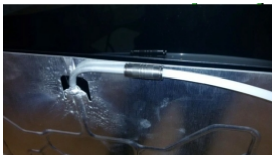
Ρακόρ για τη σύνδεση των σωλήνων PA12 8X1mm με την υδραυλική υποδοχή στην οπίσθια πλευρά των PV/T πλαίσιων
