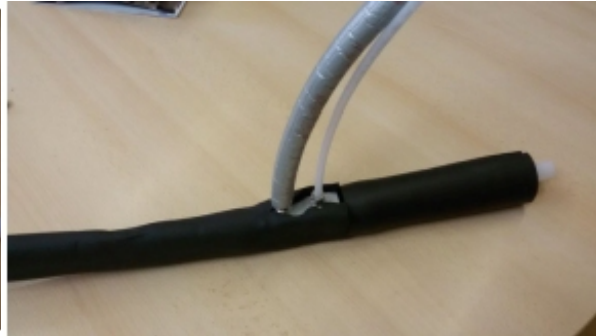
Διανομέας μετά τη σύνδεση των ρακορ, των σωλήνων και της μόνωσης.
