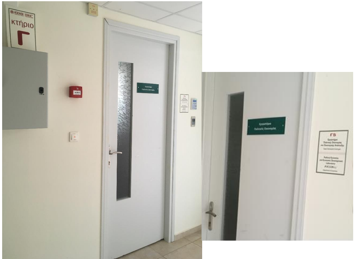
Εικόνα 7- Εσωτερικά των κτηρίων Α, Β, Γ, Δ, Ε
