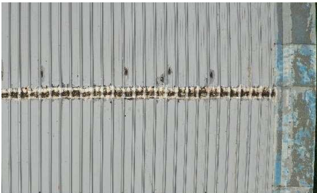
Εικόνα 1. Ενδεικτική εικόνα της μεταλλικής στέγης στην περιοχή του αρμού
