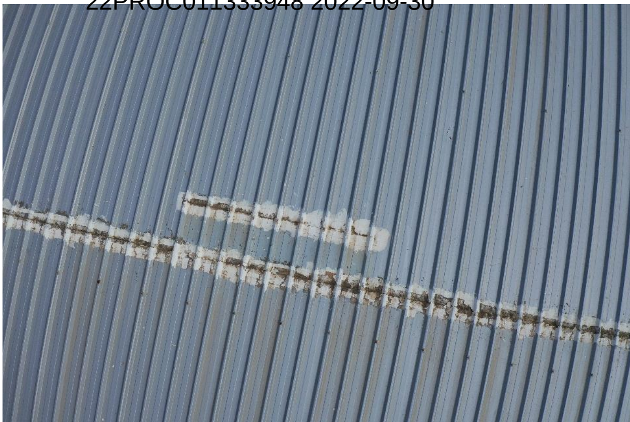
Εικόνα 2 .Ενδεικτική εικόνα της μεταλλικής στέγης στην περιοχή του αρμού
