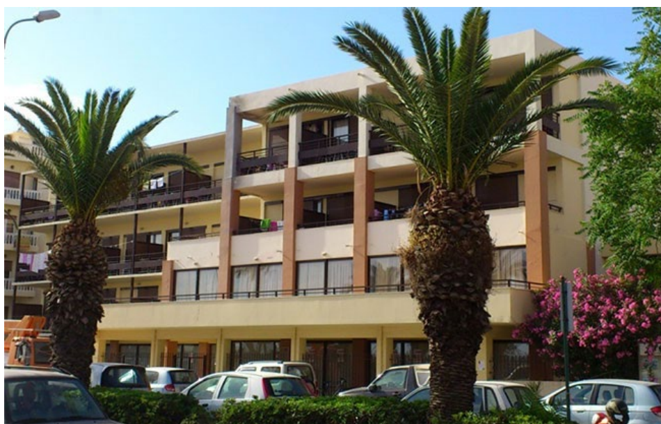
Εικόνα 2: Όψη κτιρίου από την οδό Σοφοκλή Βενιζέλου
